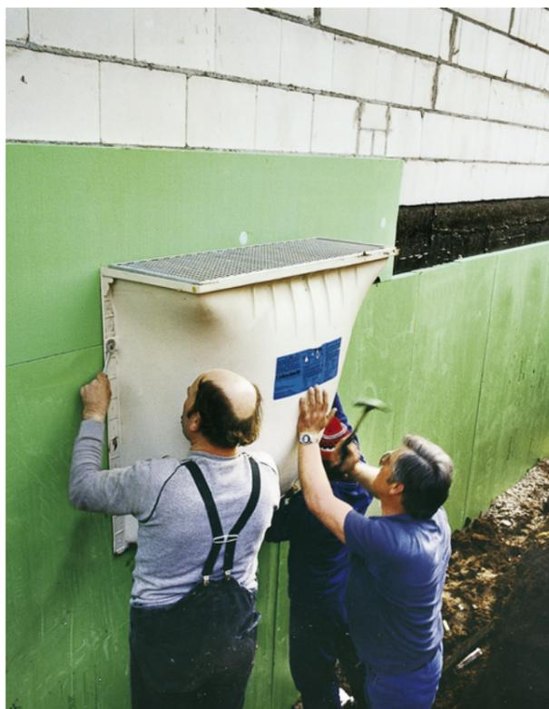
**Abb. 13:** Anbringen eines Lichtschachtes
