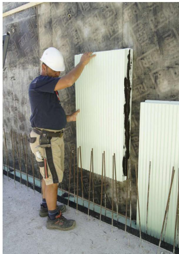
Abb. 7: Ansetzen der Styrodur® Hybrid-Platten
