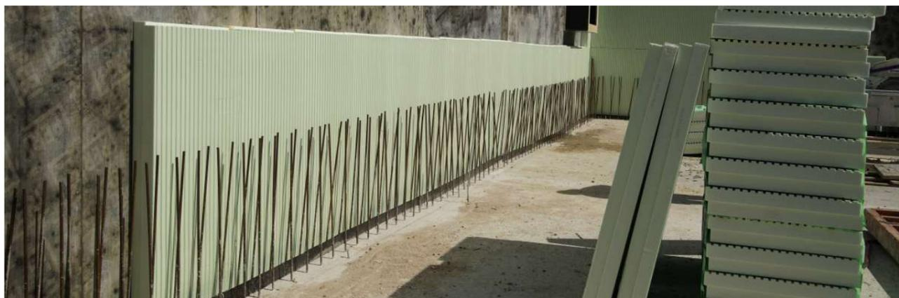
Abb. 4: Verlegung von Styrodur® Hybrid an der Innenseite der Schalung
