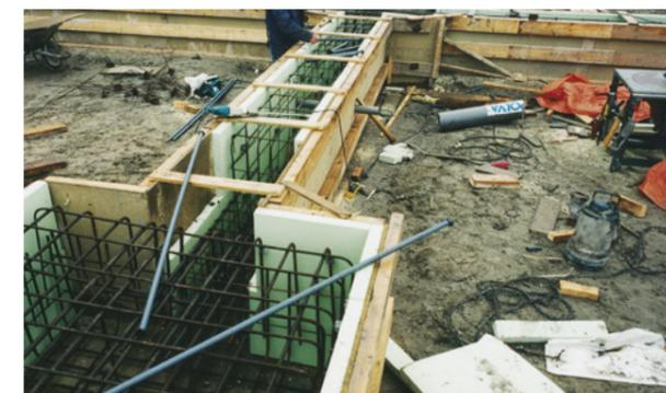
**Abb. 16:** Schalung mit Styrodur® Hybrid
