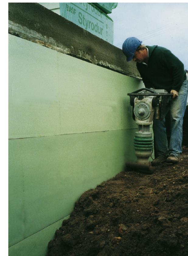
**Abb. 18:** Lagenweise Verfüllung der Baugrube und mechanische Verdichtung
