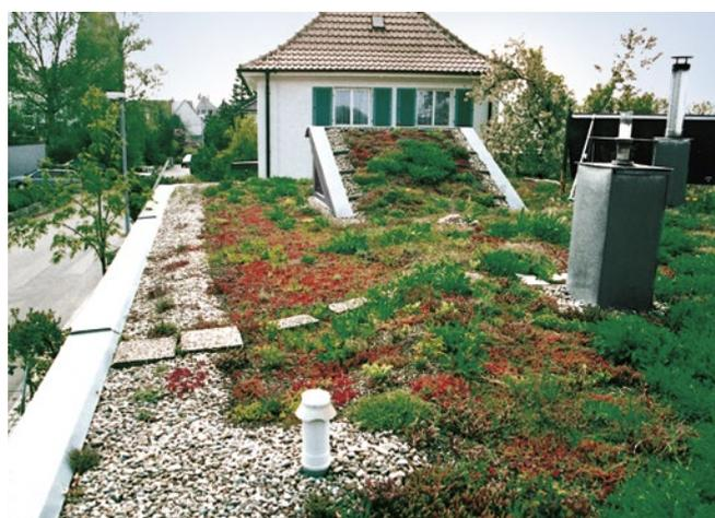
Abb. 35: Kiesstreifen am Dachrand und an Dachdurchdringungen.
