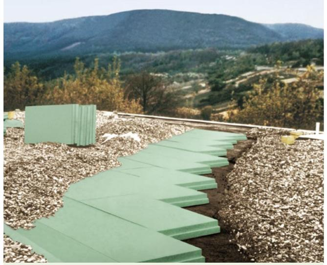
Abb. 16: Saniertes UK-Dach als Plusdachkonstruktion.
