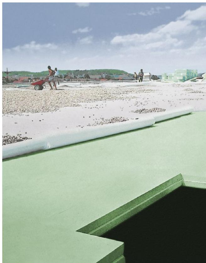
**Abb. 9:** UK-Dach mit Trennlage und Kiesschüttung.
