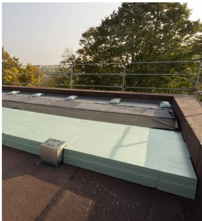
**Abb. 1:** Styrodur® ist aufgrund seiner Druckfestigkeit, geringen Wasseraufnahme und geringen Wärmeleitfähigkeit für UK-Dachkonstruktionen hervorragend geeignet, z. B. bei Flachdachsanierungen als Plus-Dach.
