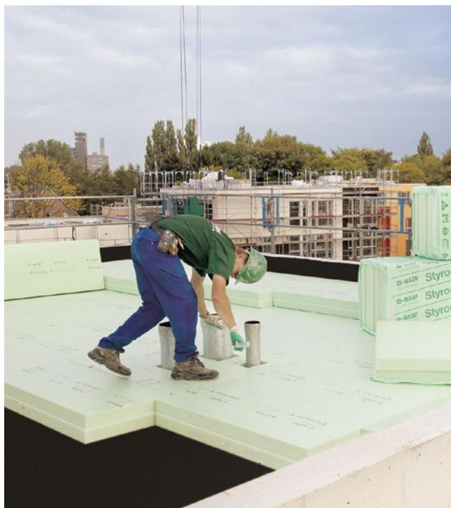
**Abb. 3:** UK-Dach-Dämmung mit Styrodur® von 250 Wohneinheiten in Hamburg.
