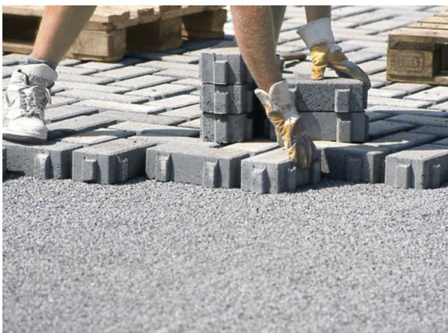
**Abb. 45:** Verbandverlegung eines Betonpflasters mit Grasfugen für einen Parkplatz auf einer Schulsporthalle.
