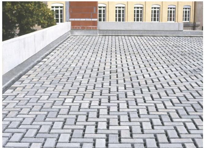
**Abb. 47:** Verlegtes Betonpflaster auf Styrodur®.
