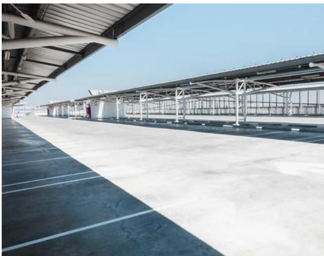
**Abb. 49:** Parkdach mit Ortbetonfahrbelag.
