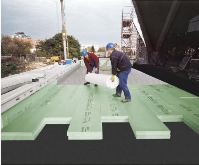
Abb. 15: Verlegung von Styrodur® oberhalb der Dachabdichtung.
