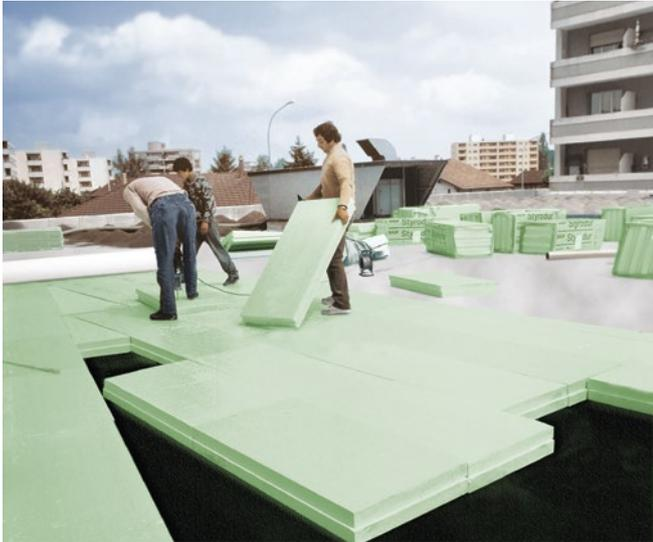
Abb. 12: Verlegung von Styrodur® beim Duodach.
