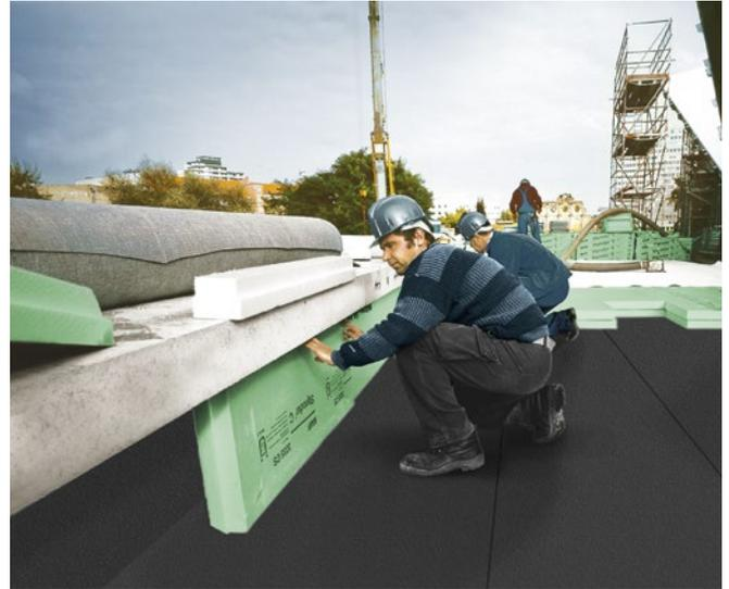
Abb. 13: Attika-Dämmung mit Styrodur®.
